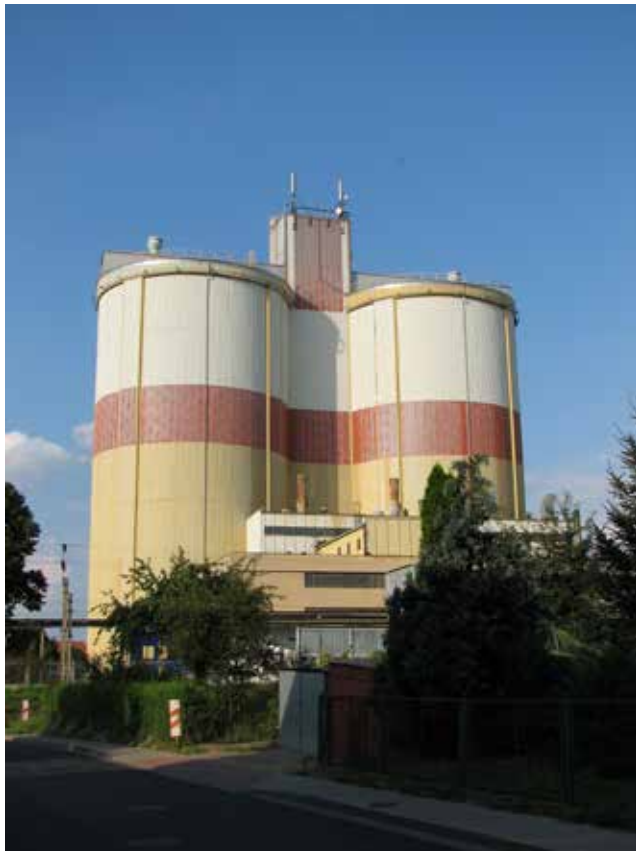
Pozostałe jeszcze silosy cukrowni (Fot. DAC)
