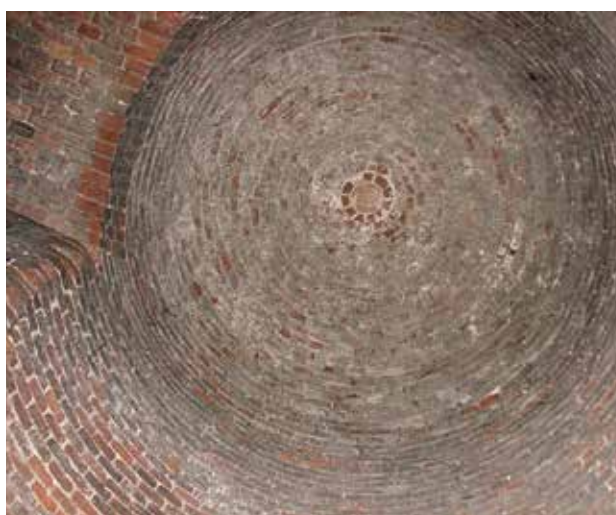
Ceglany sufit w wewnętrznej klatce schodowej wieży (Fot. DAC)
