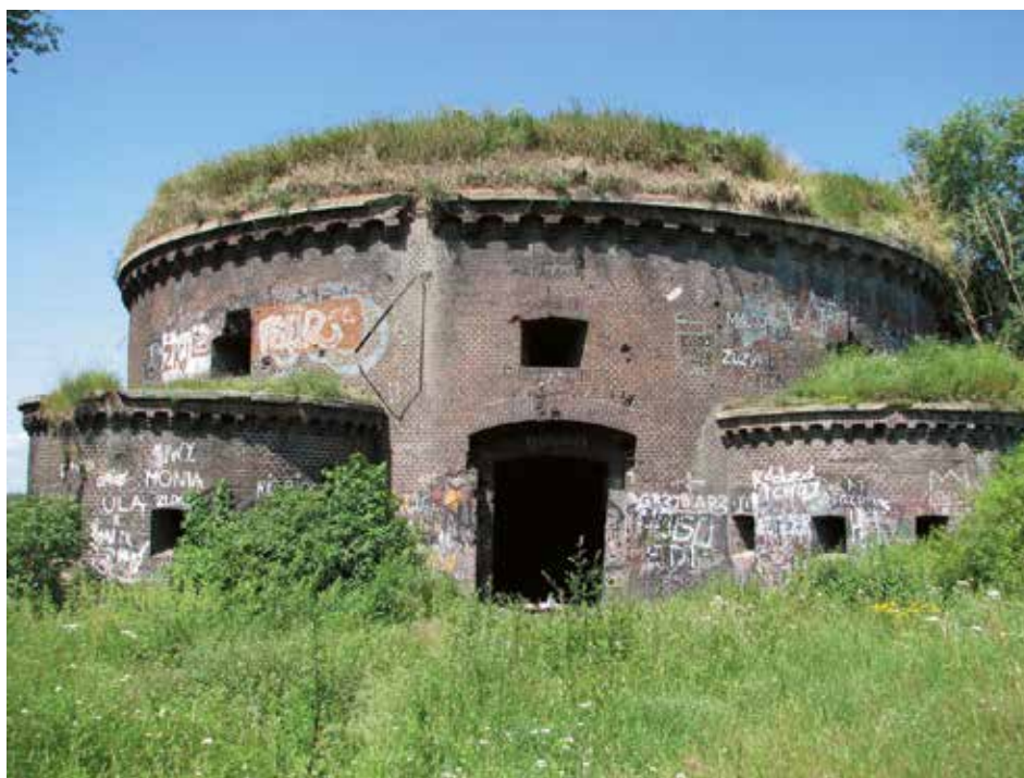
Wieża artyleryjska, stan obecny (Fot. DAC)
